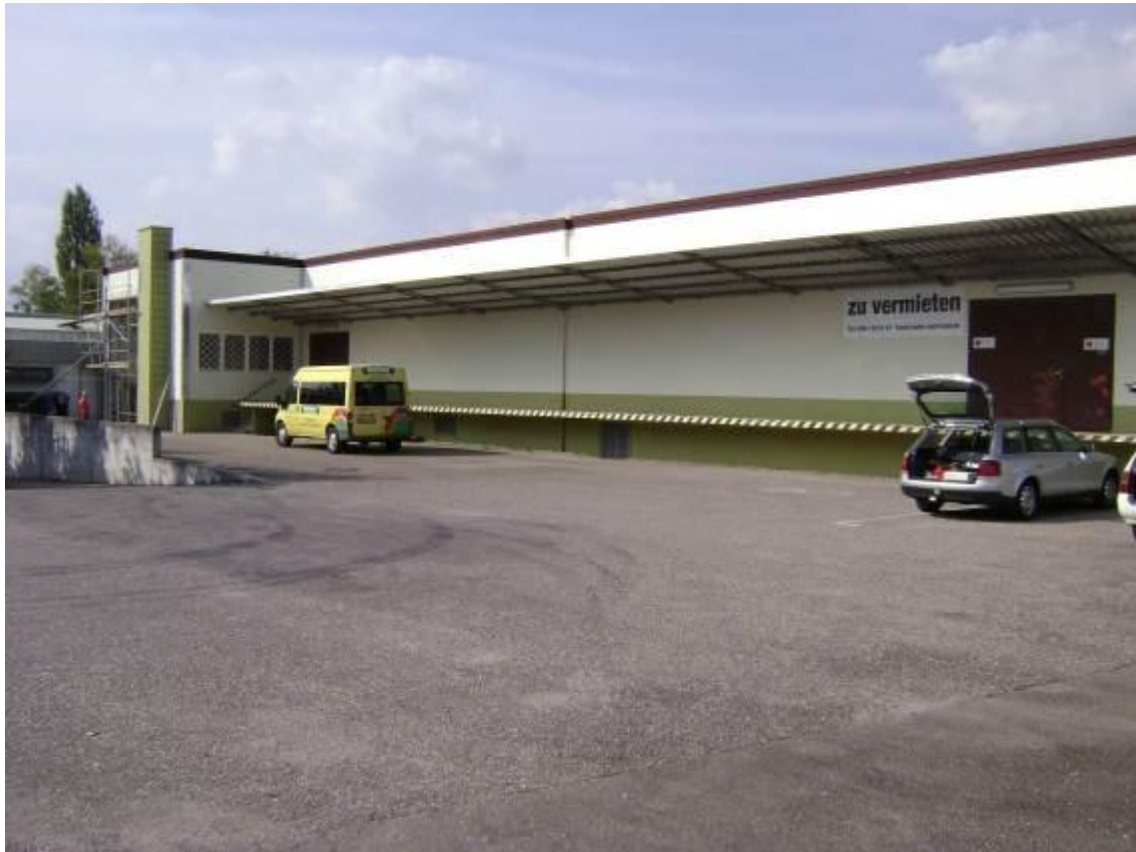
Nordansicht mit Laderampe und LKW Rangierhof
